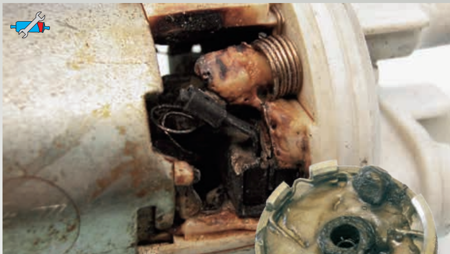
Рис. 20: Повреждения из-за расплавления в результате работы всухую
